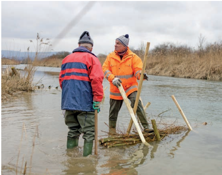
Zuletzt wird das Rutenbündel unter je zwei X-förmigen Holzkreuzen in Position gebracht.
